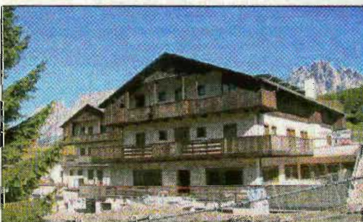
A ZUEL Ecco il "Rosapetra" in fase di ultimazione: aprirà all'inizio del 2011
